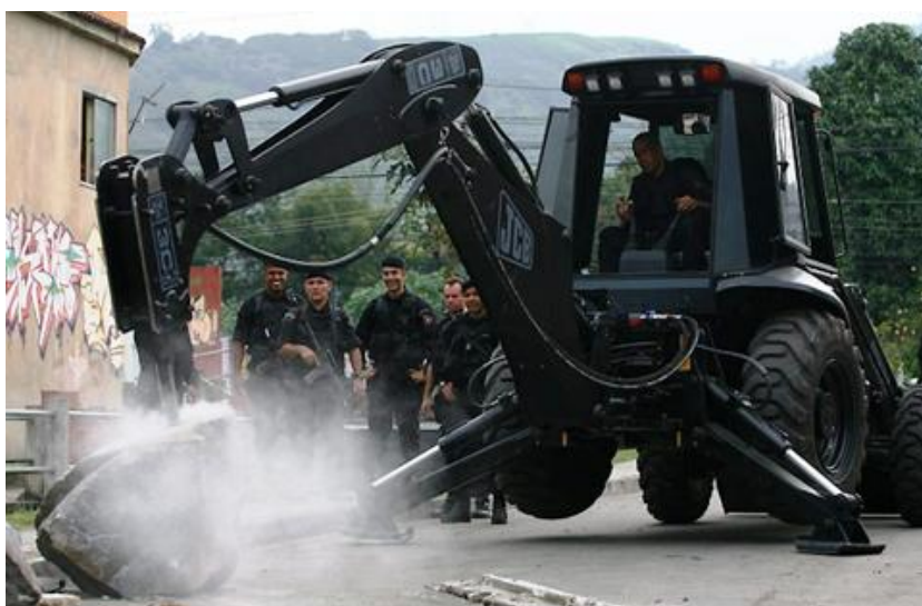
Figura 3: Britadeira na Retroescavadeira do Bope Fonte: oglobo.globo.com/rio (2009)
