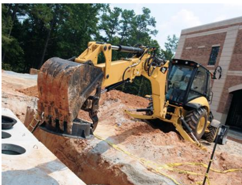
Figura 4: Caçamba traseira com pinça Fonte: brasil.cat.com (2011)
