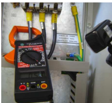
Figura 36: Medição de corrente com o multímetro no painel traseiro.
